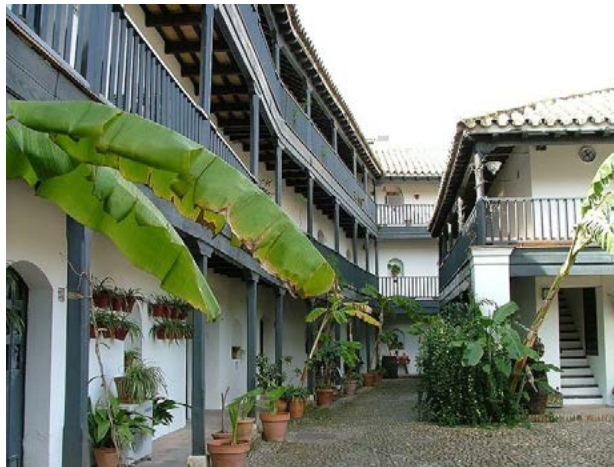
Ilustración 28 Vista interior de la Corrala del Conde, año 2004. Autor: Alonso Pozo Ruiz Fuente: https://es.wikipedia.org/wiki/Corrales_de_vecinos_de_Sevilla#/media/Archivo:RI-51-0004389_Corral_del_Conde-Sevilla_04.jpg
